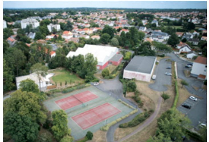
Site de Chantepie avant travaux
